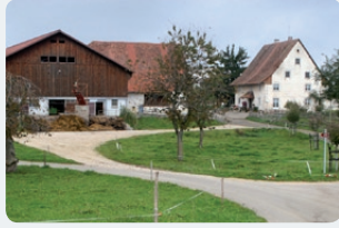
Le village se prolonge par des fermes isolées
